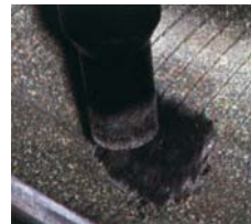
4. Пылесосом удалить пыль после шлифования.
